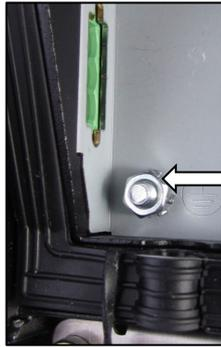
Abbildung 14-5: Erdungsbolzen mit Mutter
